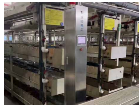
智能巡检机器人
