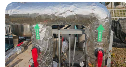
厂区内增设回收管网及水泵
